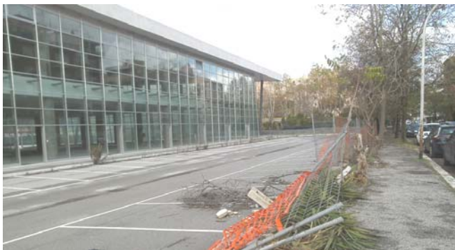
Sopra: Il brutto edificio per uffici di piazza dei Navigatori fa da sfondo ai due tronchi della via dal centro e dall'EUR. Sotto: L'immagine indecorosa di abbandono degli edifici commerciali fra piazza dei Navigatori e via S. Petronilla..
