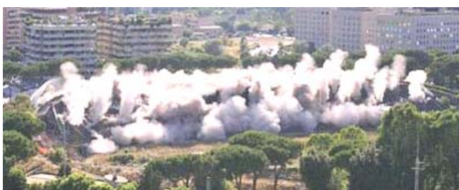
La demolizione per esplosione di dinamite del Velodromo.
